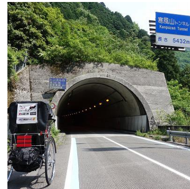
道中で最長四国の寒風山トンネル5433m 片側1車線で横をトラックが走り抜ける恐怖。 交通事故が1番のリスク
